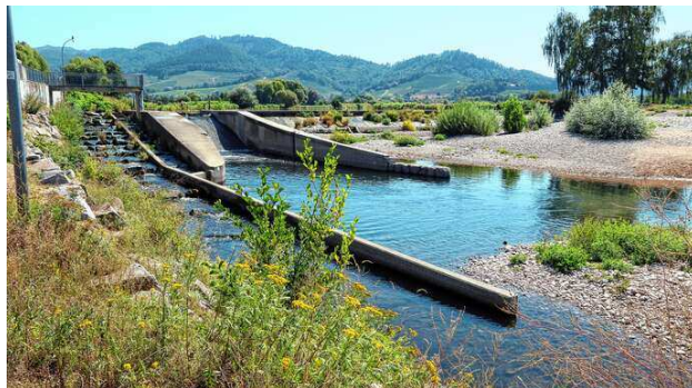
Die Baggerarbeiten am „Großen Deich“ sehen die Angler kritisch. ©Archivfoto
