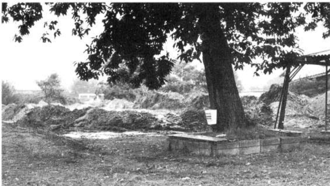
Bild 17 Der Festplatz entlang des Mühlbachs ist zum Schlamm lager geworden. Damit sich der immer noch dünnflüssige Schlamm nicht ausbreiten kann, werden Kies-Sanddämme aufgeschüttet. Rechts im Bild erkennbar die Überdachung der Fest-Küche.
