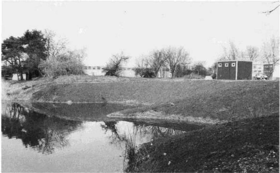
Bild 33 Das Gelände und die Böschungen sind mit Mutterboden angedeckt, rechts im Bild die neu errichtete Toilettenanlage.
