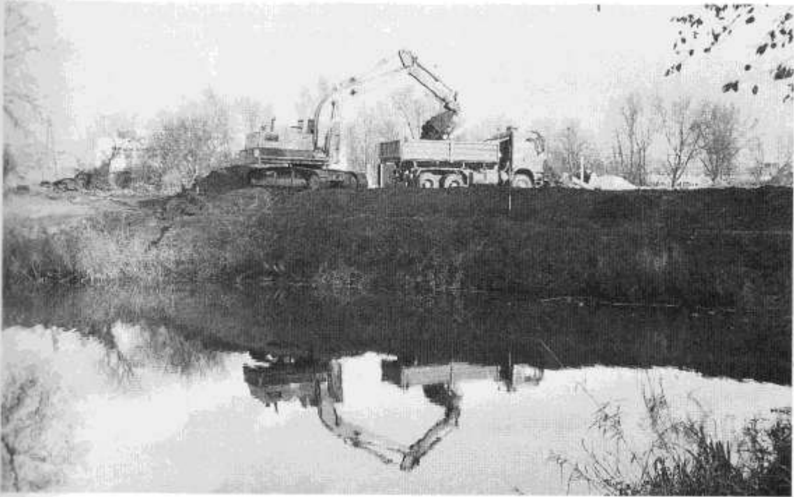
Bild 31 Der Bagger ist am 21. Nov. 1994 angerückt und hat mit dem Aushub begonnen.
