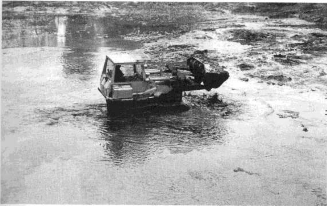
Bild 14 Mit dem Frontlader wird der Schlamm zur Entwässerung an die Uferränder geschafft und später auf dem alten Festplatz gelagert.
