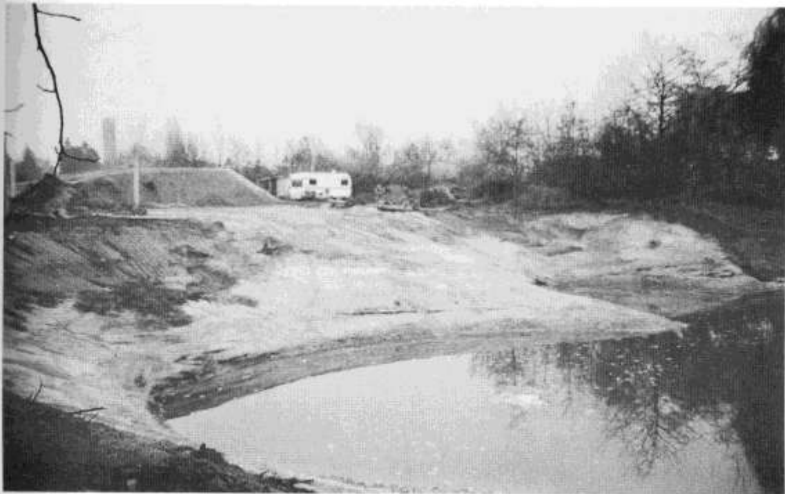
Bild 32 Drei Tage später, die Konturen der beiden Flachwasserbuchten sind erkennbar und modelliert.
