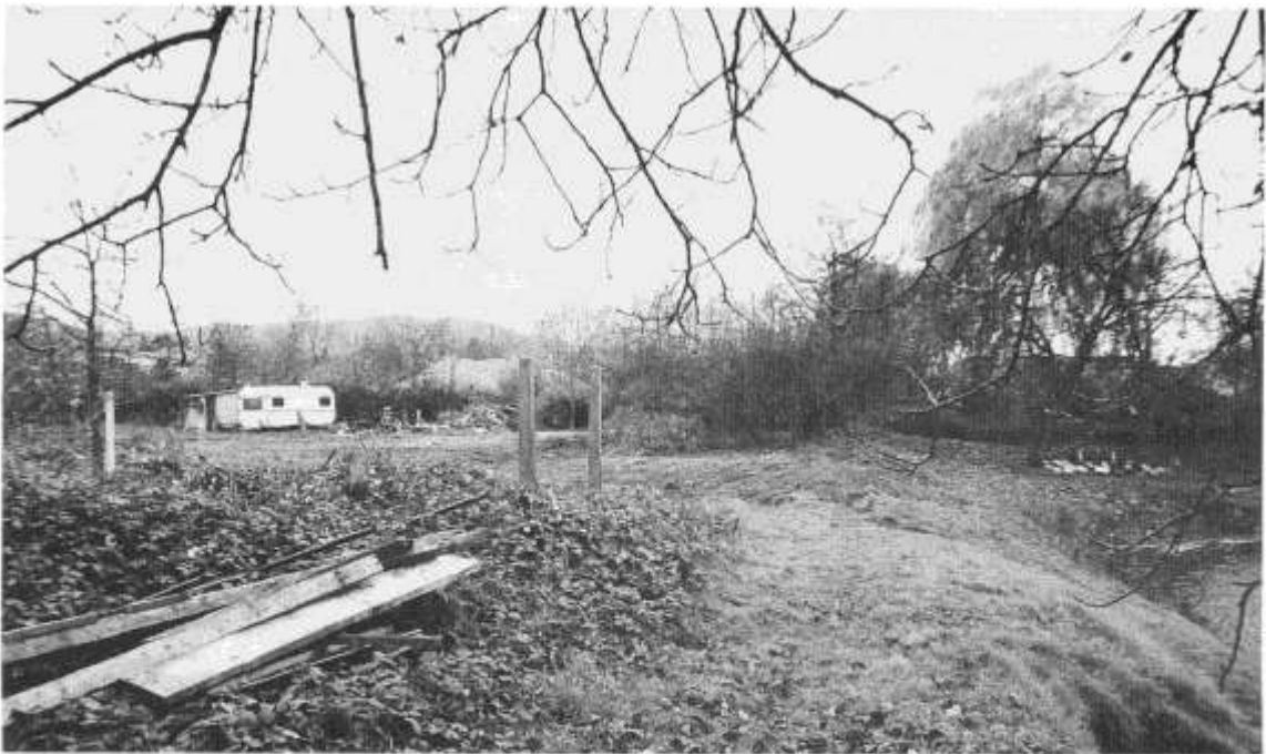
Bild 30 Drei Wochen später, das Gelände des ehem. Landfahrerplatzes ist abge- räumt sowie der Zaun zum Seewinkel abgebaut, die Erdarbeiten können beginnen.
