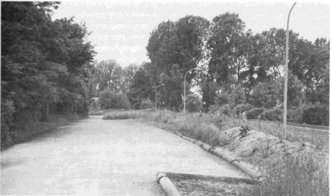
Bild 39 Mit der Verlegung der Kinzigstraße wurde auch der Flutgraben geschlossen. Die Zufahrt zum Vereinsheim ist jetzt nur noch von der Mühlbachseite her möglich.
