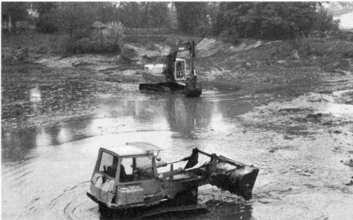
Bild 12 Schlamm wird zur restlosen Entwässerung des Seebodens zur Seite geschoben und mit dem Bagger Rinnen ausgehoben, damit das Wasser an die tiefste Stelle des Sees abfließen und abgepumpt werden kann.
