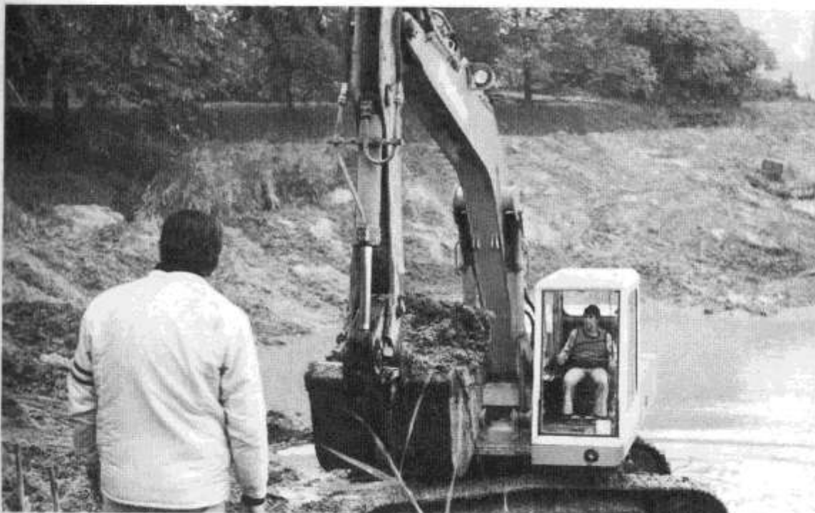
Bild 15 Die Uferränder und Böschungen werden mit dem Bagger rekultiviert und teilweise neu modelliert.
